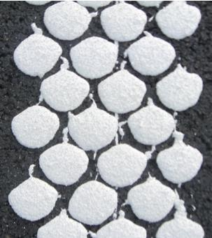
*ViaTherm® wird vielerorts für Spezial- und Strukturmarkierungen eingesetzt – hier im ViziSpot® System*
