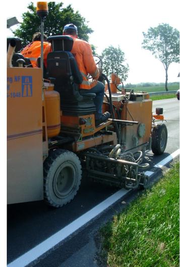
*ViaTherm® wird für Standard und Spezialmarkierungen eingesetzt*
